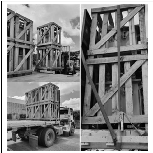
Figura 17: Cargue y aseguramiento de la primera fila
