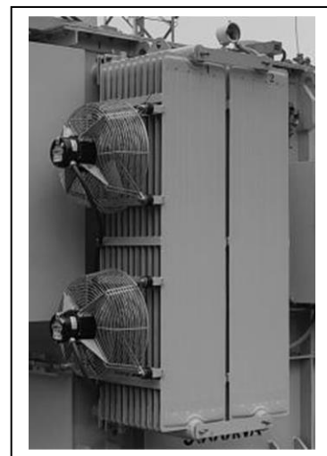
Figura 76: Instalación ventiladores
