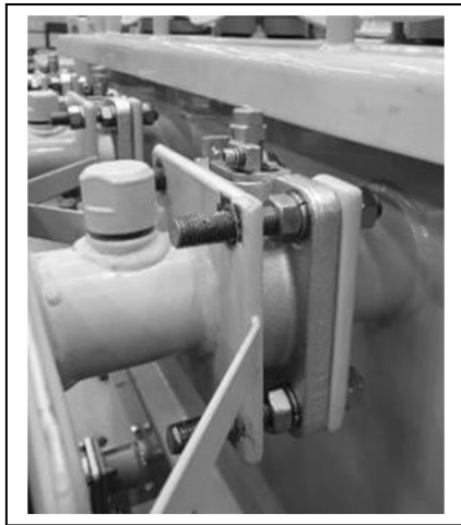
Figura 39: Desajustar y retirar tuercas
