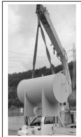
Figura 77: Montaje tanque conservador
