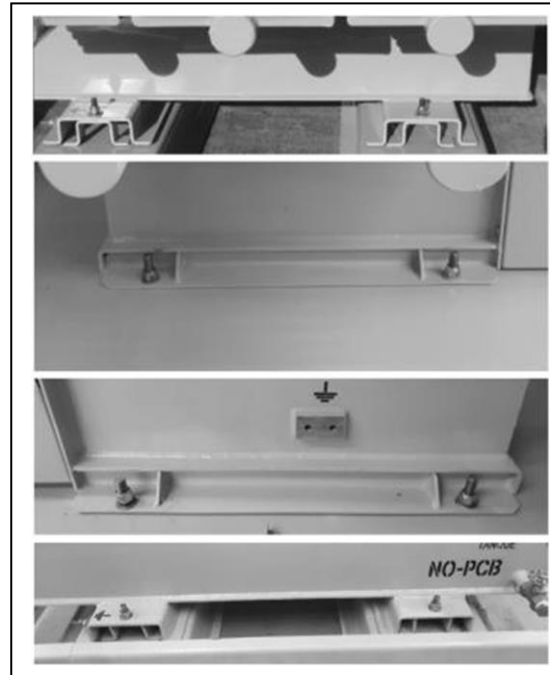
Figura 15: Anclaje con tornillos del transformador a la base
