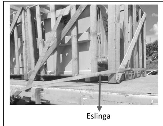
Figura 30: Aseguramiento última fila transformadores cargados
